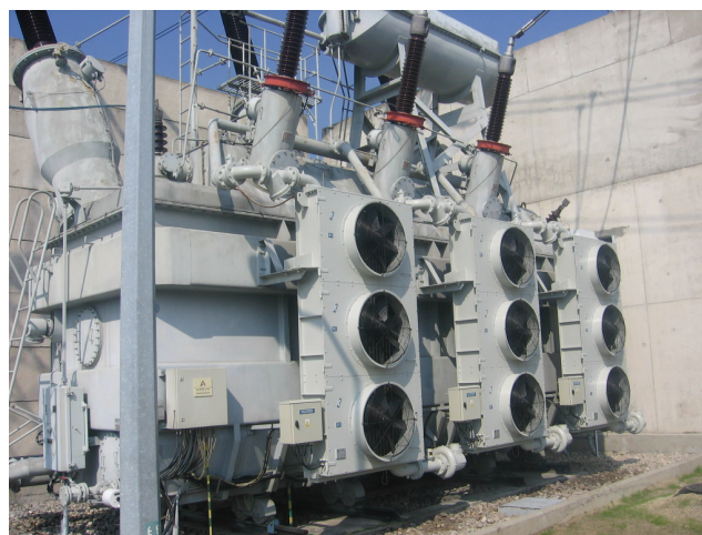
Rys.1. Przykładowy transformator z zainstalowanymi chłodziaczami
